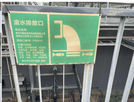
图 4.1.23 生产废水排放口标识标牌
