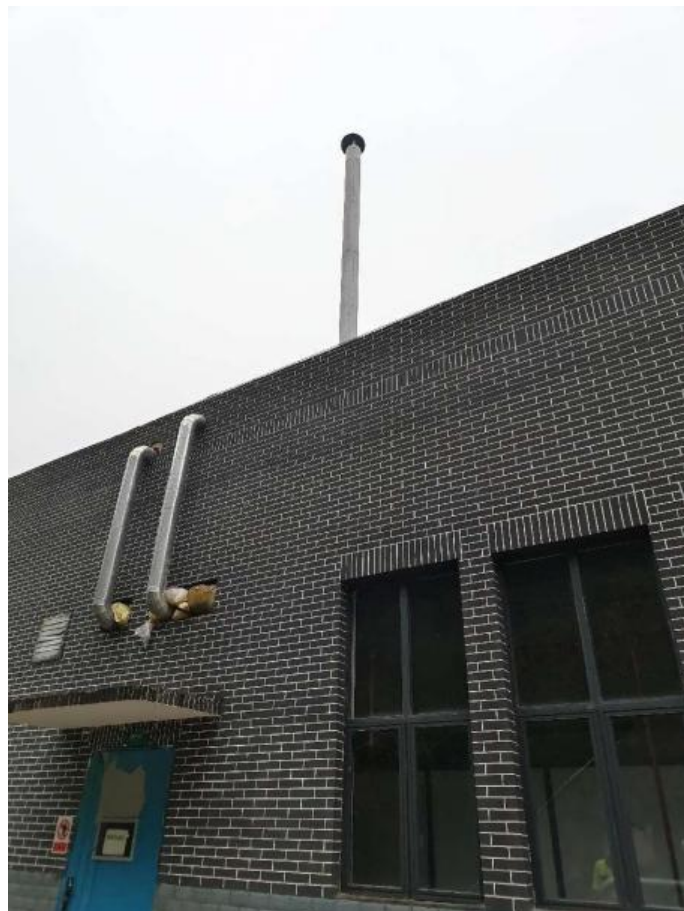
锅炉房排气筒
