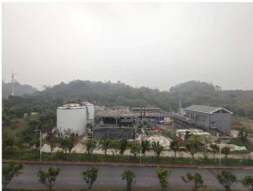
图 4.1.15 污水处理站现场照片
