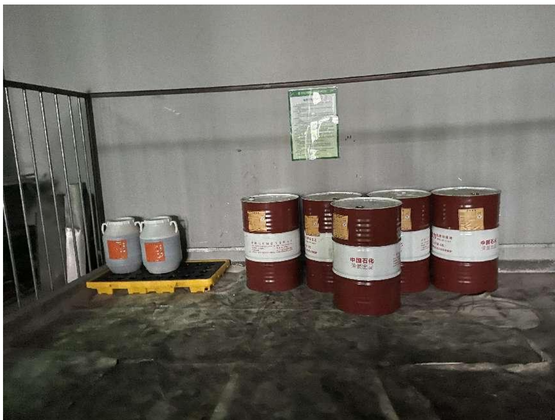
危废暂存间（托盘及围堰） 附图3 环保设施现状图
