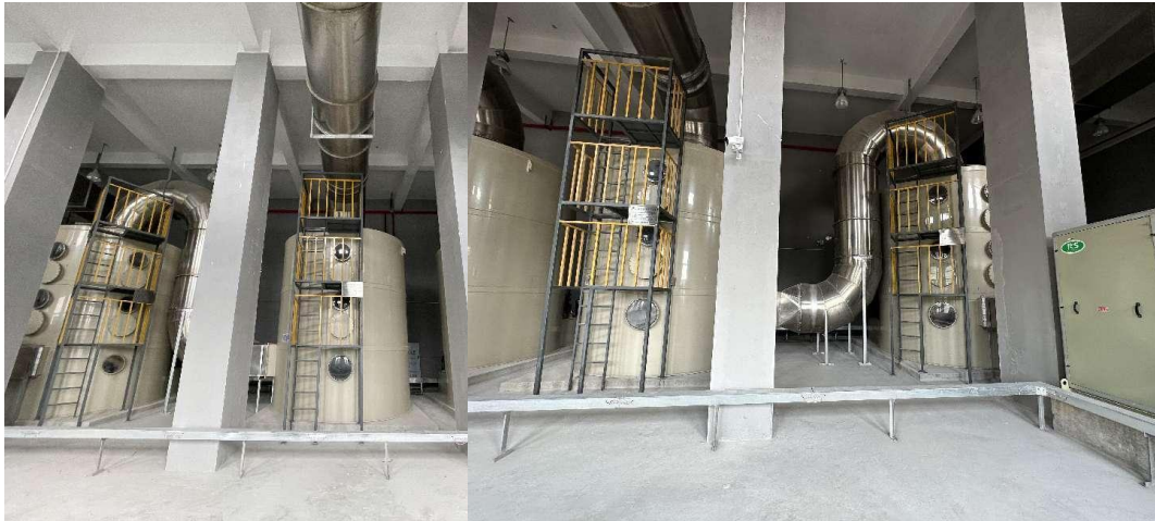
餐厨转运间废气处理设备照片（化学洗涤塔+植物液洗涤塔，左 2 串联，右 2 串联）
