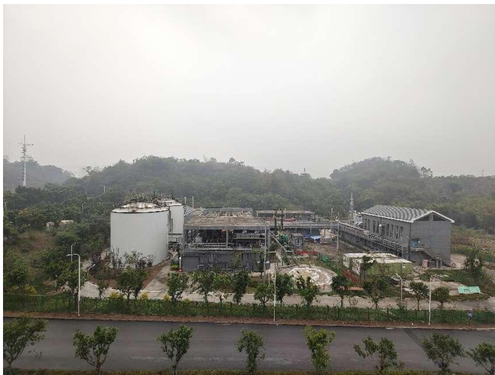
污水处理站（生产废水+生活污水）
