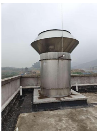
图 4.1.3 排气筒照片
