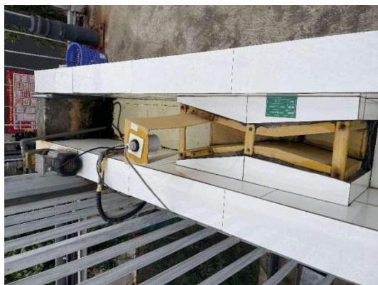
图 4.1.22 生产废水排放口流量计
