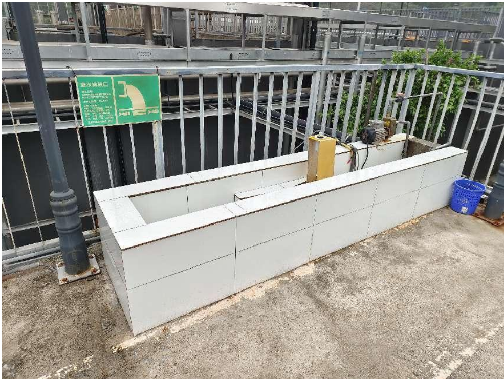
生产废水排放口
