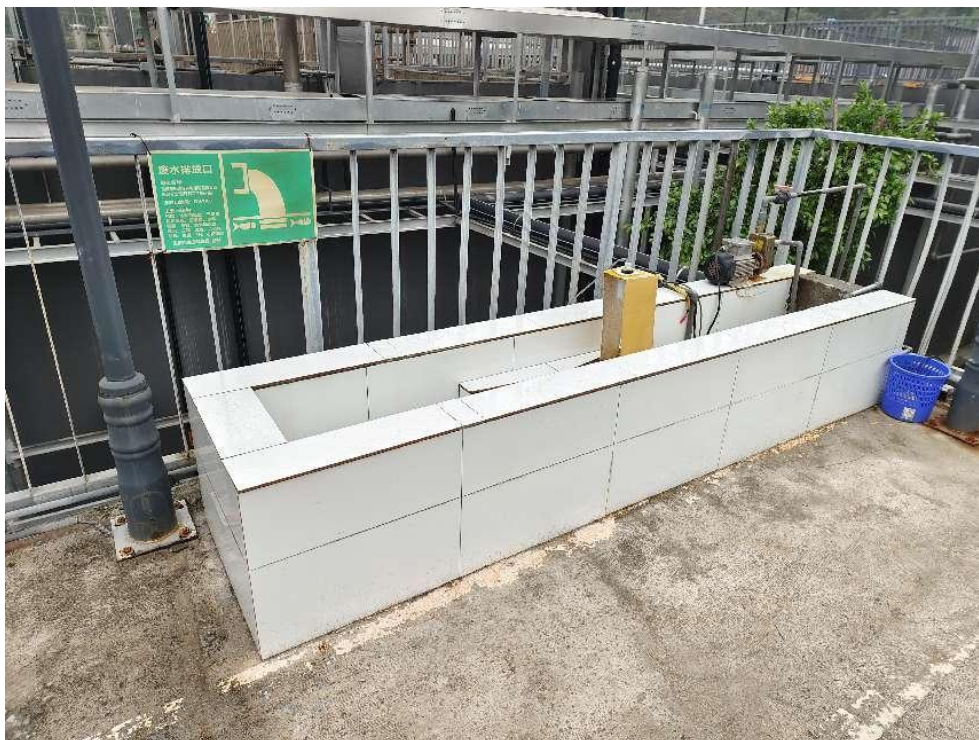
图 4.1.16 生产污水处理后排放口现场照片
