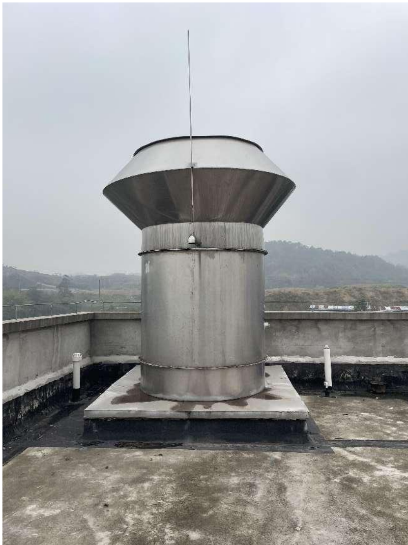
餐厨转运间废气处理设备照片（化学洗涤塔+植物液洗涤塔，左 2 串联，右 2 串联）
