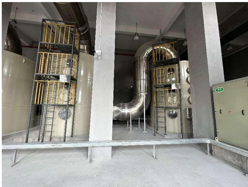
图 4.1.2 植物液洗涤塔、化学洗涤塔处理设施现场照片（2 套）
